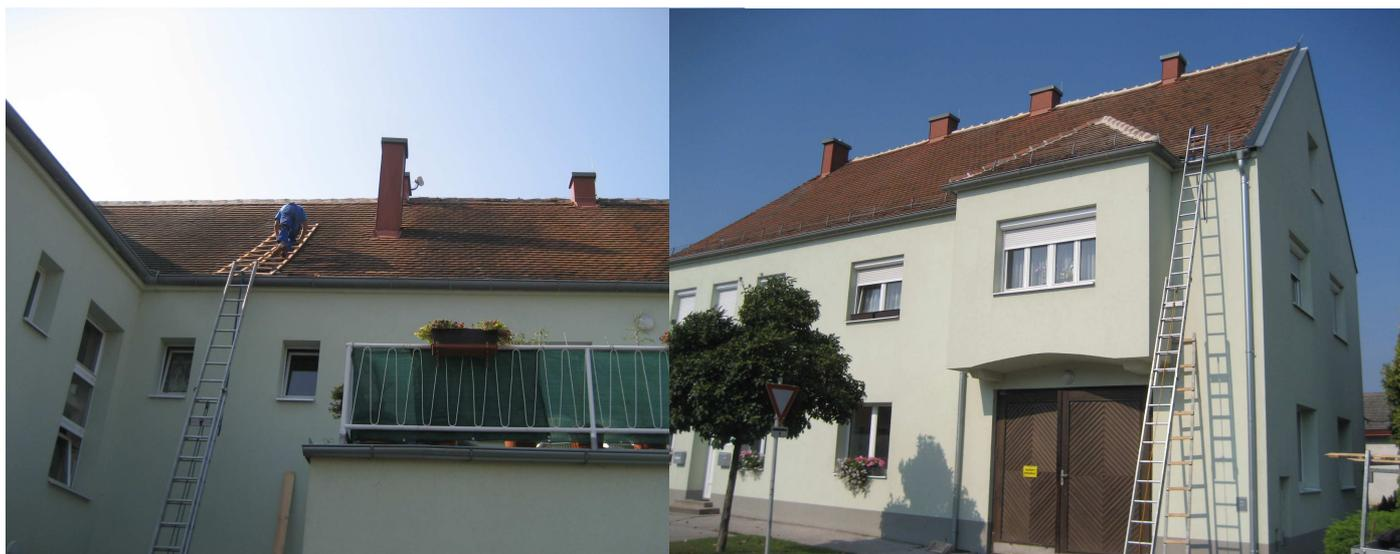
Wegen Wind- und Sturmschäden am Dach des Gemeindehauses in Unterpullendorf mussten Dachziegel erneuert werden sowie die Firstkappen neu einzementiert werden. Dadurch soll verhindert werden, dass durch herabfallende Teile, Verletzungen bzw. Beschädigungen passieren.
